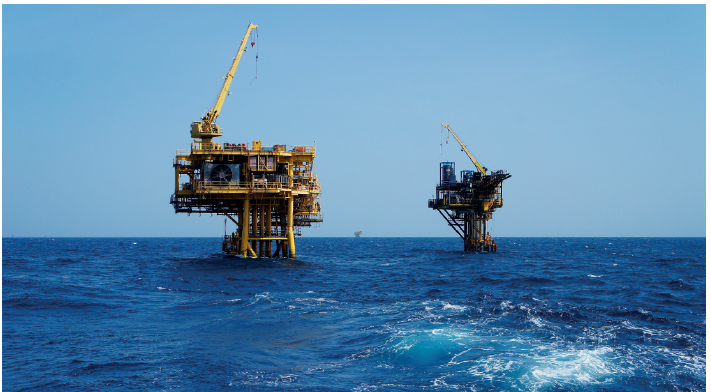
Plataformas de producción offshore en aguas someras
